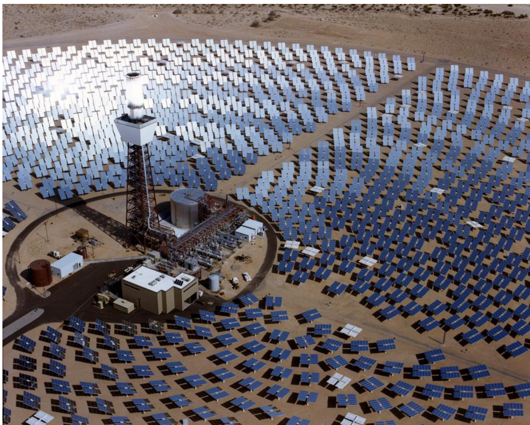
شکل ۱۵۴: نمایی از یک نیروگاه برج خورشیدی
