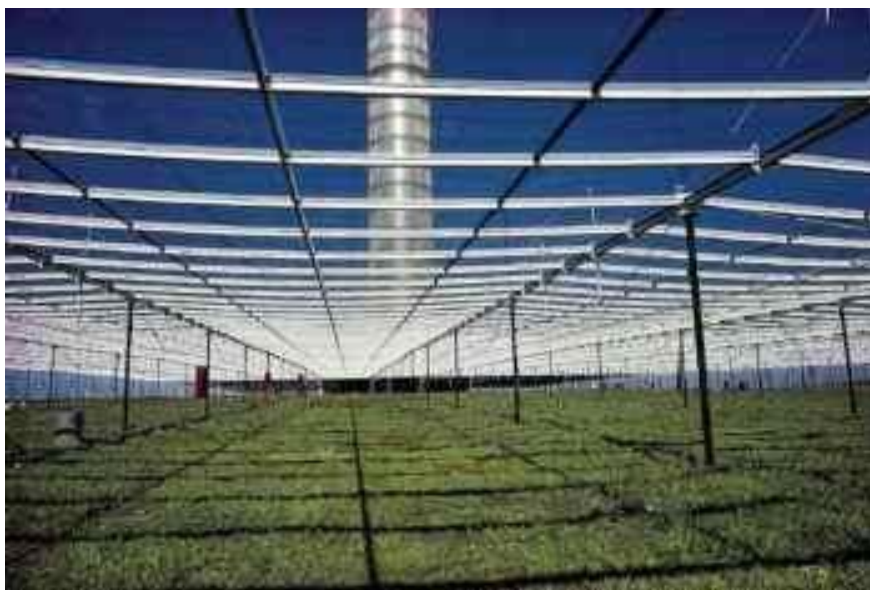
شکل ۳۲: نمایی از سطح زیر کلکتور دودکش خورشیدی [14]
