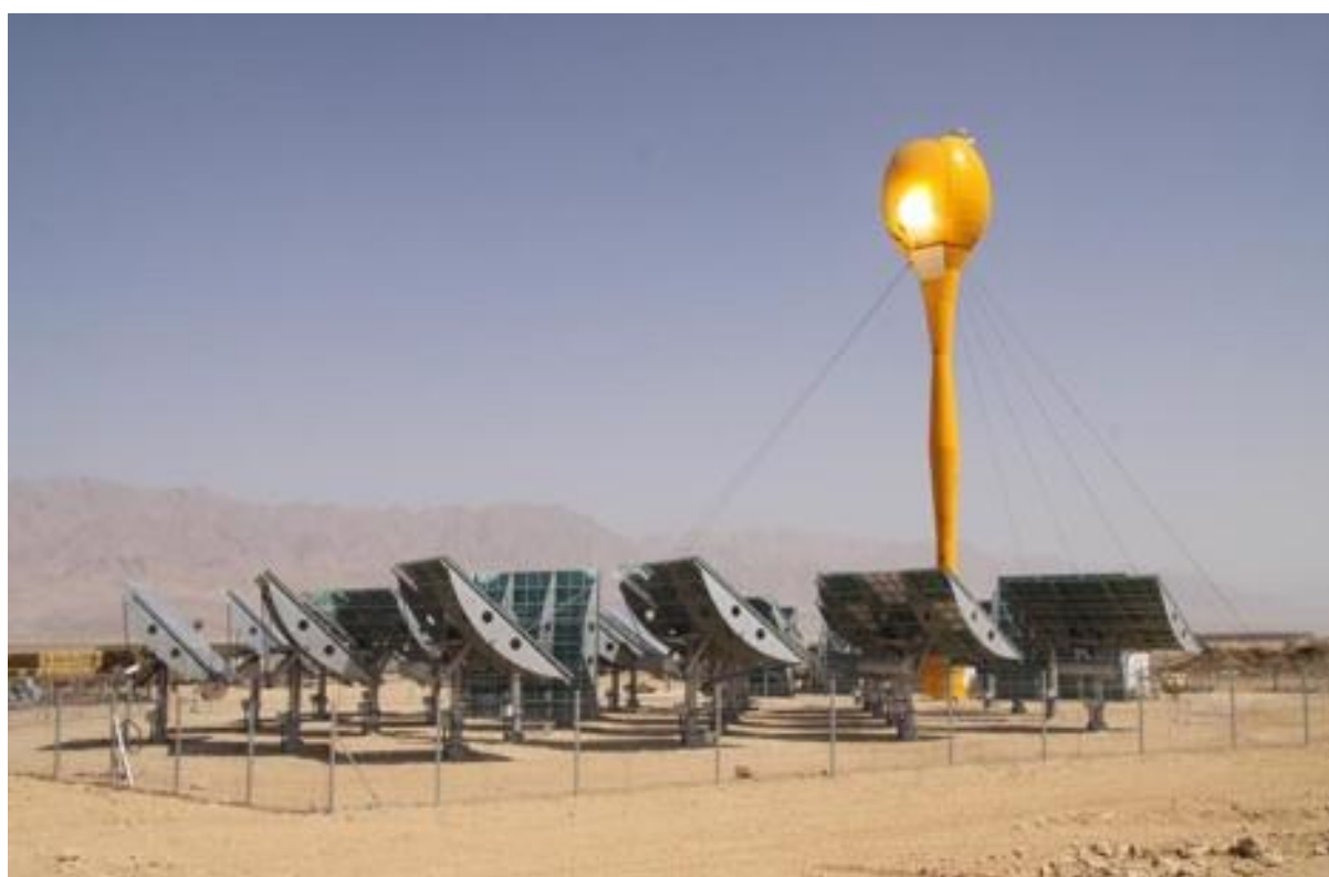
شکل ۵۸: استفاده از نمک نترات در هلیوستات‌ها [14]
